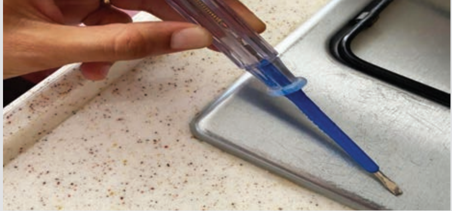
Şekil 2: Kontrol kalemi ile mutfak ocağında elektrik kaçağı kontrolü
