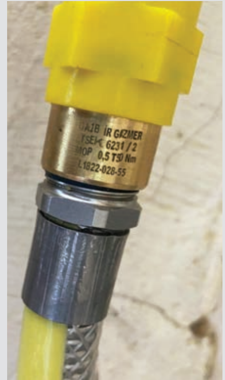
Şekil 1: Ocak bağlantısında izolatör kullanımı
