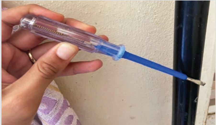
Şekil 3: Doğalgaz borusu elektrik kaçağı kontrolü
